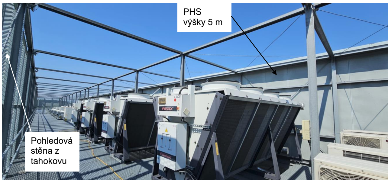
Obr. 11.2 Pohled na stávající chladicí jednotky na střechě IT4I.
